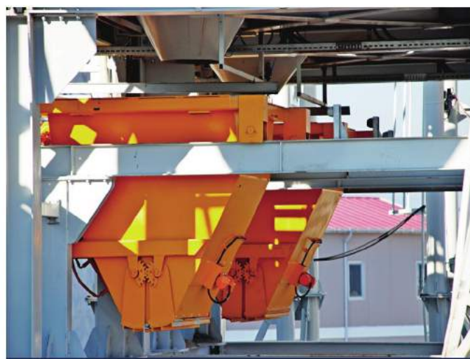
Кубели для адресной подачи бетона
