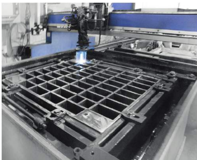
Резка стального блока для матрицы
